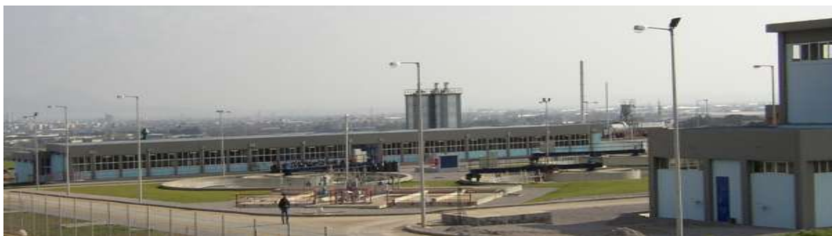
Διυλιστήριο Θεσσαλονίκης - Κεντρική μονάδα διύλισης
