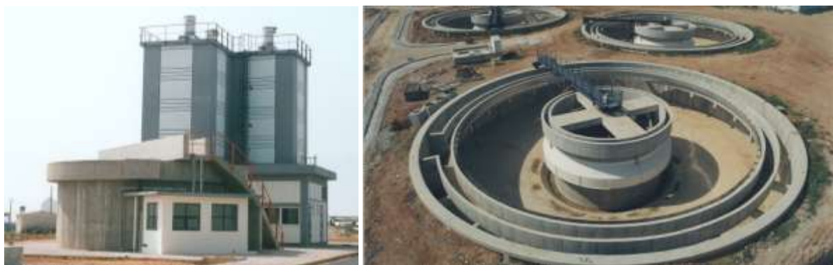
Διυλιστήριο Θεσσαλονίκης - Σιλό ασβέστη και δεξαμενές καθίζησης
